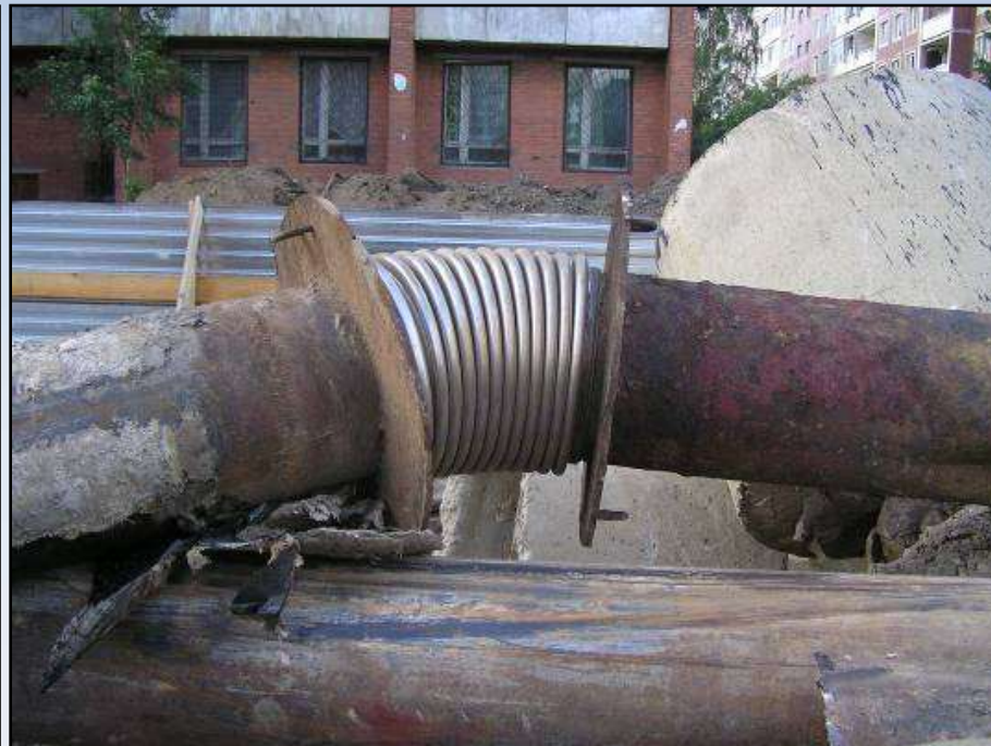
Компенсатор после демонтажа трубопровода. 2008г.
